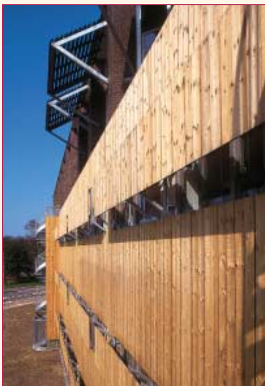
△ 2. Een nieuwe ontwikkeling is houtsoorten als grenen te modificeren. Stellac Wood aan verzamelkantoor Den Daalder in Boxtel. Ontwerp: Min2 bouw-kunst Bergen.
